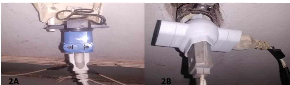
Figura 1: Tomadas mal dimensionadas e utilização de "T"
